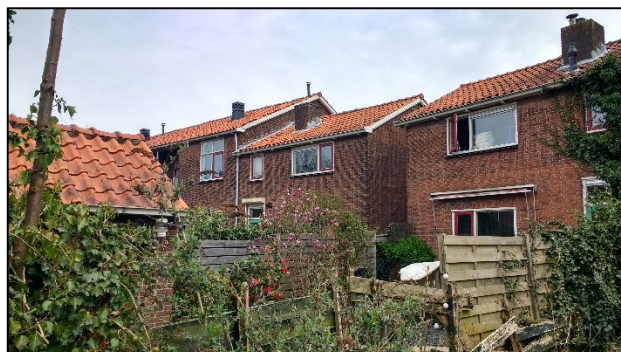
Foto 2: Achtertuinen woningen, verwildeerde groenstructuren
