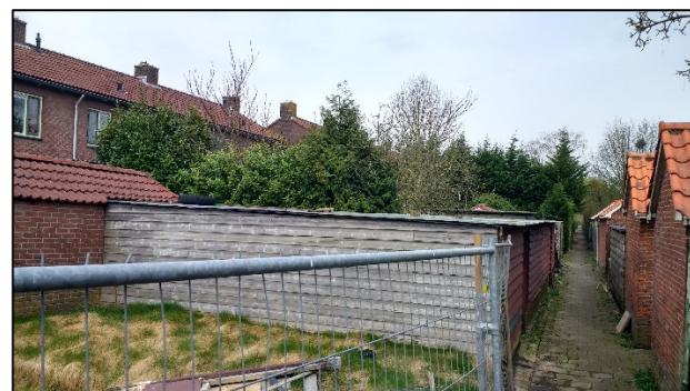
Foto 4: Achtertuinen woningen, verwildeerde groenstructuren
