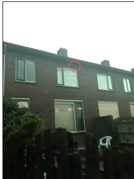
Afbeelding 4: Locatie uitvliegopening zomerverblijfplaats gewone dwergvleermuis D.F. Pauwstraat 40.
