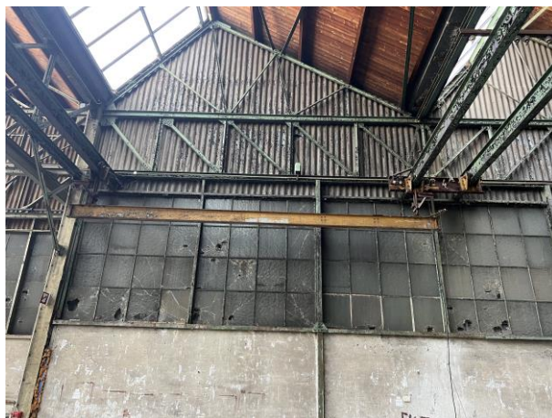
Afbeelding 2. Vakwerkliggers bouwdeel 2A
