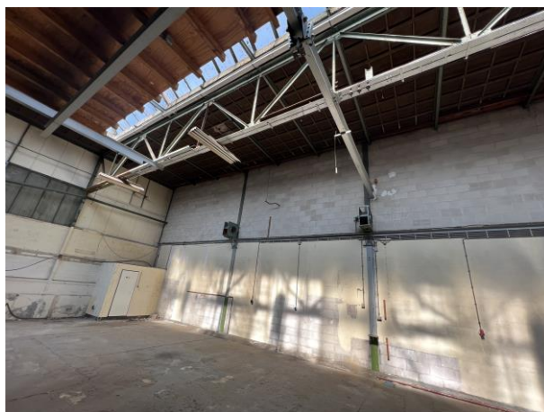
Afbeelding 1. Constructie spanten gebouw 1
