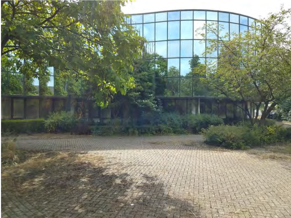
Afbeelding 1: deellocatie A, vooraanzicht kantoor Houtwarenfabriek
