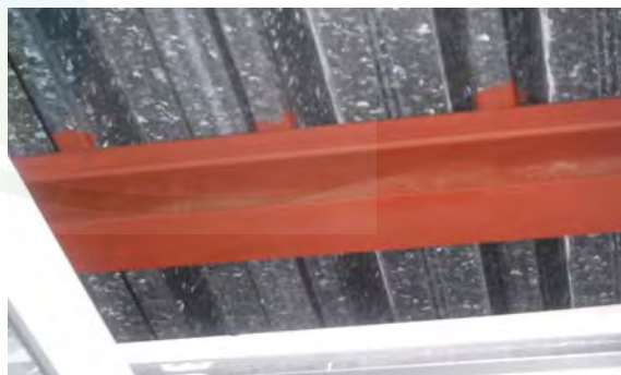
Stalen damwand 1e verdieping
