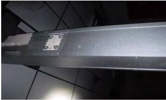
Asbesthoudende plaat verticale rondom kolommen
