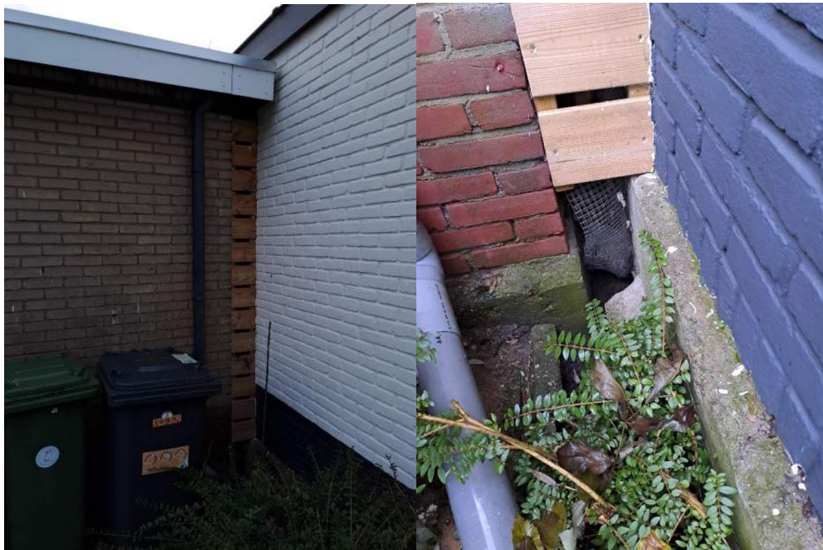
Te slopen schuurtje met achterwand (links) en daaronder een holte (rechts).
