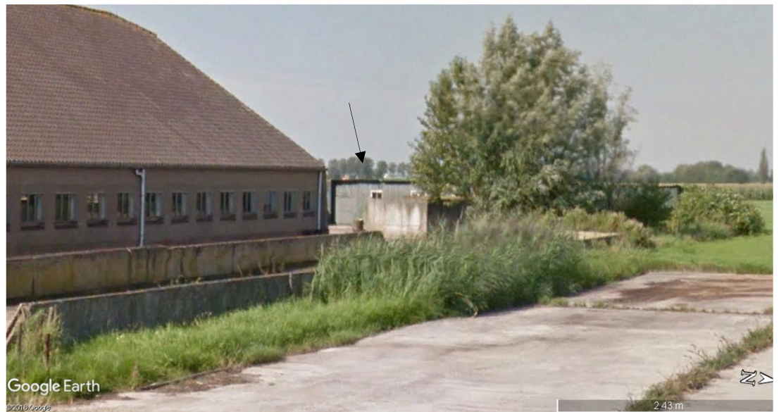
gesloopte houten schuur achterzijde
