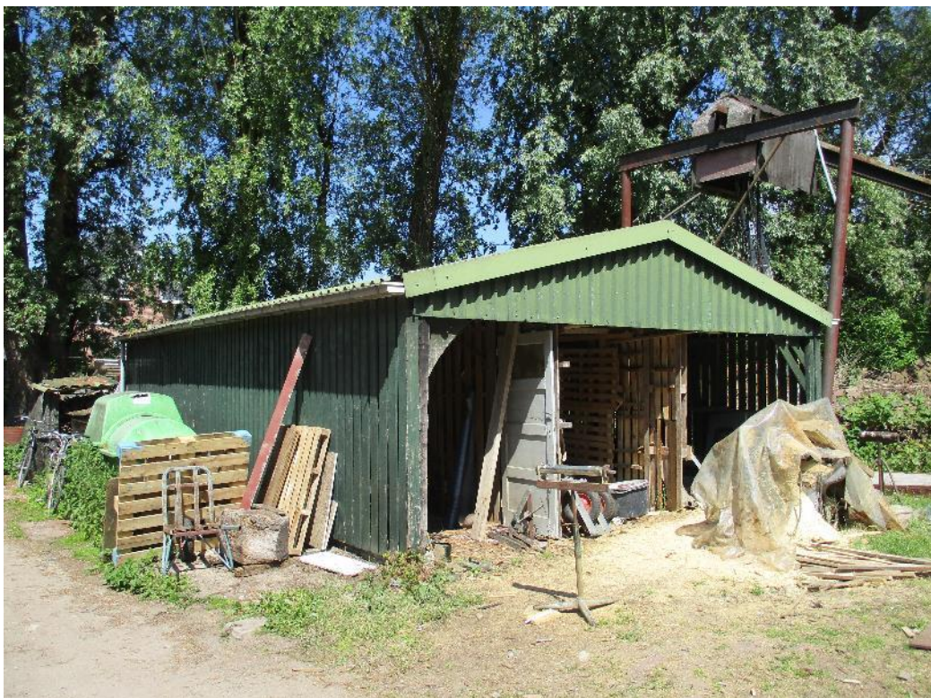
Figuur 4 Het terrein wordt aan de achterzijde omgeven door een rij hoge bomen. Hier is tevens een houtschuur gelegen welke is opgetrokken uit metalen damwandplaten en hout.
